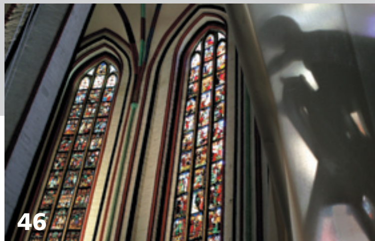
Mittelalterliche Bleiglasfenster restauriert.
